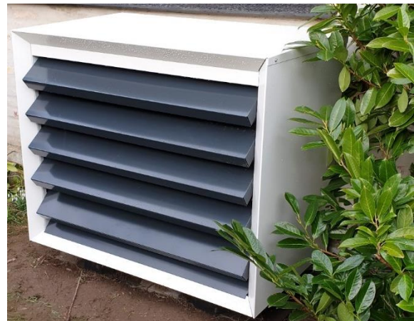
Villa fra 1934 på 200 m 2 – varmepumpens udedel indbygget i kabinet ses nederst. Foto: DGC
